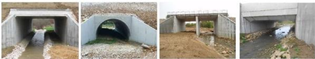
Joonis 3. Truupid, mis on kohandatud ka loomadele läbipääsuks. 30
